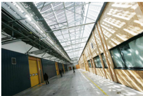
Réalisation d'une verrière photovoltaïque dans un bâtiment industriel
